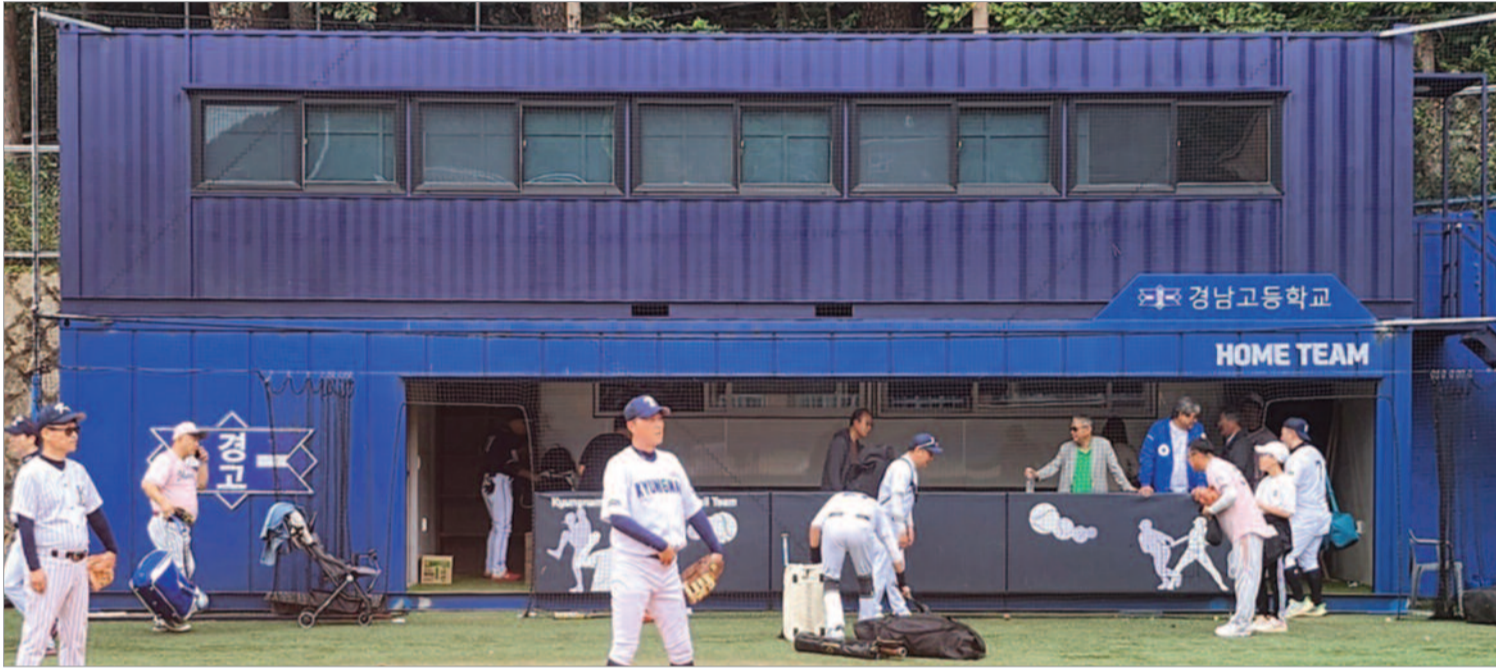
홈쪽 덕아웃에 설치된 2층 락커룸
