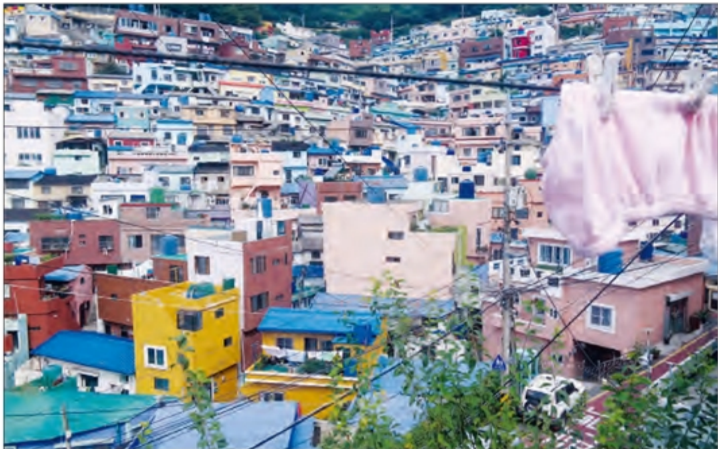
감천문화마을 전경. 1955년에 생겼다. 세월이 흐르는 동안 처음의 루핑 지붕이 함석이나 슬라브로 바뀌었고 새로 지어진 집도 늘어났으나 기하학적인 마을 배치는 달라지지 않았다.
